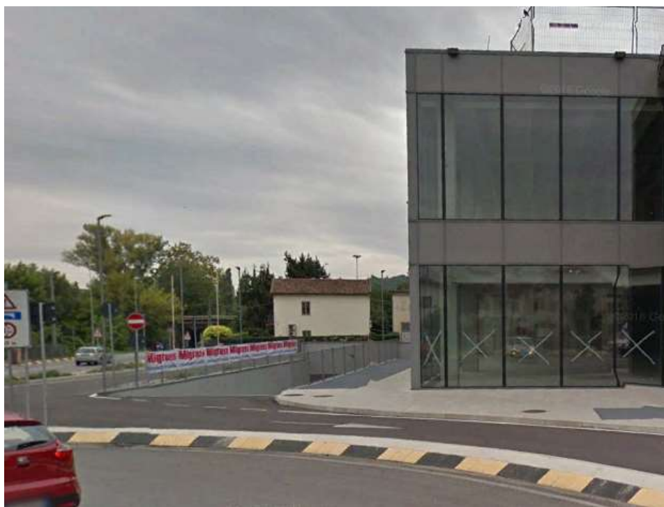
Foto di griglia a cielo aperto sul lato ovest della struttura e rampa di accesso al piano interrato
