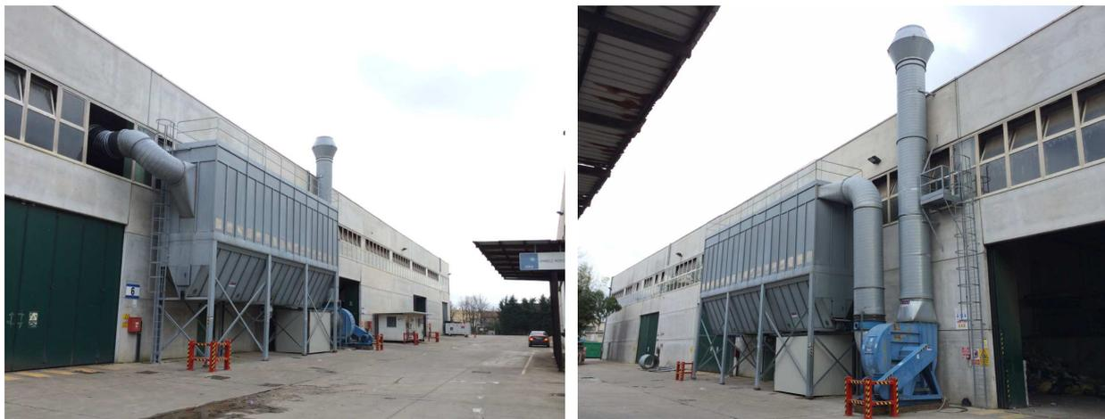
Foto 5. Viste dell'impianto di filtrazione. Si noti la cabina insonorizzata per la riduzione del rumore prodotto dall'impianto pneumatico.
