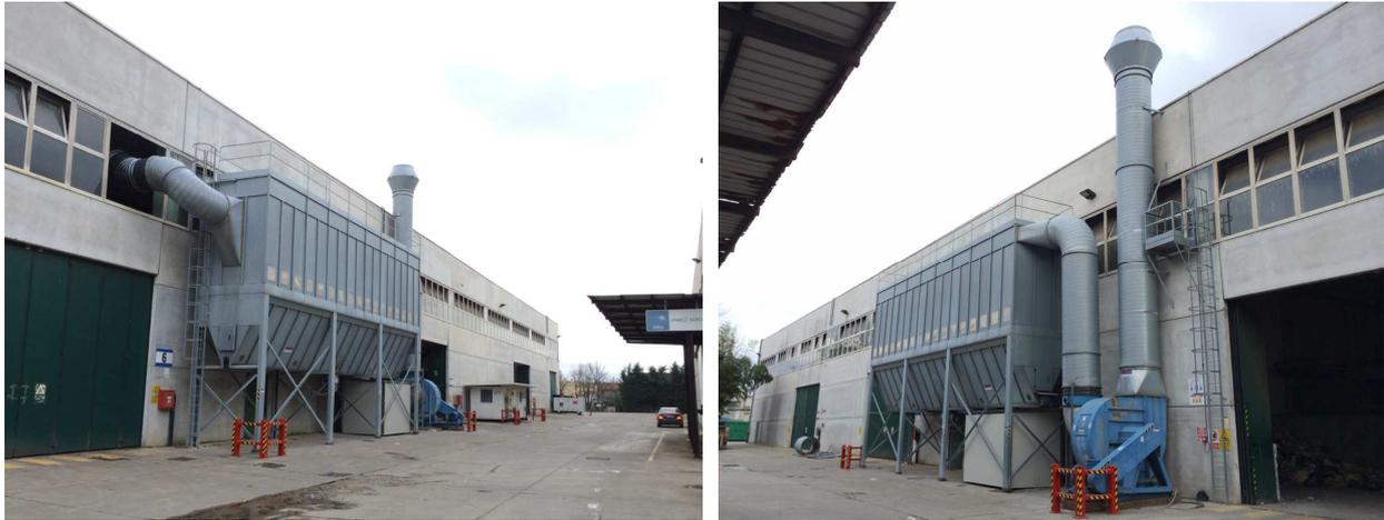
Foto 5. Viste dell'impianto di filtrazione. Si noti la cabina insonorizzata per la riduzione del rumore prodotto dall'impianto pneumatico.
