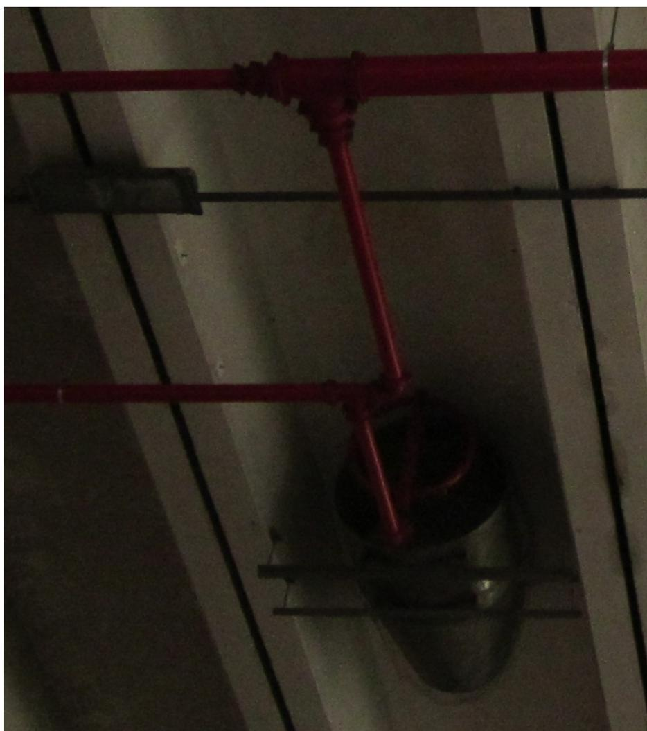
**Fotografia 2:** Vista generatore schiuma alta espansione statico
