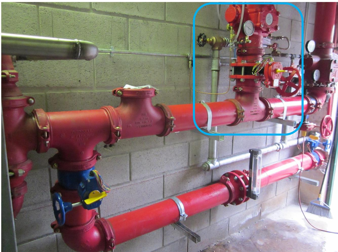
**Fotografia 1:** Vista collettore valvole a diluvio. Viene evidenziata la nuova valvola a diluvio  $\varnothing 6''$  a protezione del Locale Deposito.
