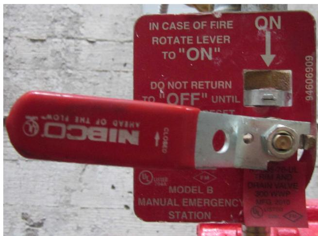
**Fotografia 6:** Particolare valvola manuale di attivazione di emergenza
