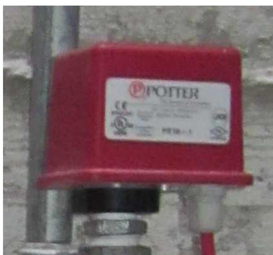
**Fotografia 5:** Pressostato di allarme
