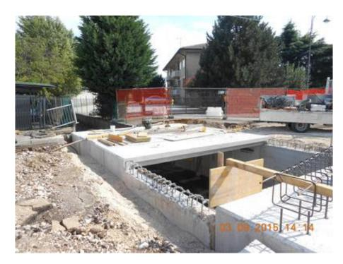
Foto 2 - Realizzazione scatolare lungo via Trento
