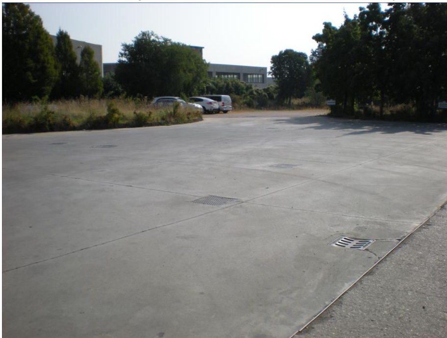
Foto 6. Una porzione del piazzale esterno dell'impianto.
