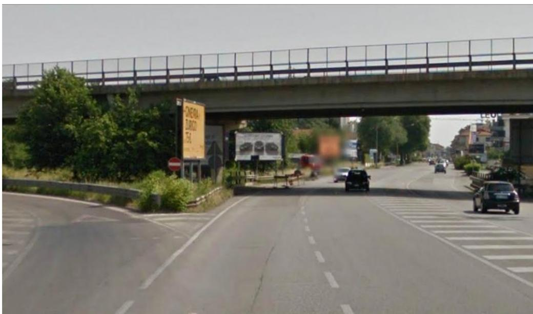
*Figura 4.19 – Intersezione a livelli sfalsati tra SR11 e Viale del Sole*
