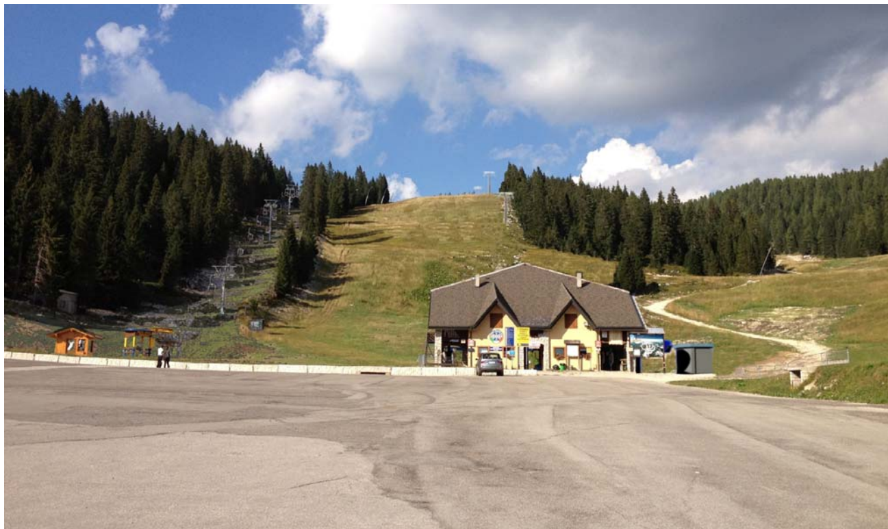
Foto 5.2. CONTESTO VASTO – Stato di progetto : Visione estiva da sud dell'area della stazione di valle dell'impianto. Come già sottolineato, la fascia di ingombro della linea si ridurrà significativamente, così come il numero dei sostegni e delle seggiole, inoltre, l'ampliamento del taglio boschivo è talmente ridotto da non esser costituire una differenza percepibile rispetto all'attuale. Anche il volume della stazione di valle, per quanto di dimensioni significative, non risulta visibile da sud, grazie alla quota ribassata del
