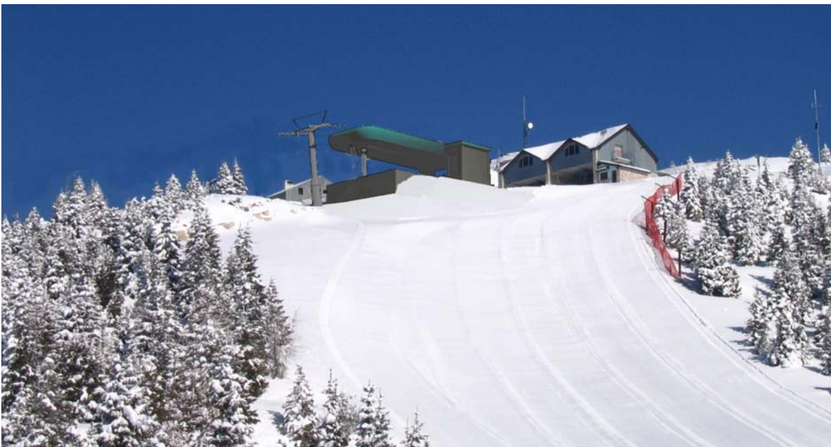
Foto 5.8. CONTESTO INTERMEDIO – Stato di progetto : Visione invernale da sud-est della stazione di monte. Anche in questo caso, si constata un’accezione migliorativa delle opere in rapporto alla diminuzione del numero di sostegni (da 4 a 1), funi (da 4 a 2) e seggiole. Relativamente alla geometria del manufatto della stazione, questa è in parte aggettante rispetto al declivio naturale del pendio, per quanto raggiunga circa la stessa elevazione dell’attuale falcone dell’ultimo sostegno doppio. Tuttavia, si può osservare che la geometria di progetto appare molto più lineare e logica rispetto a quella in essere, in quanto la morfologia artificiale del rilevato esistente crea delle scarpate nette e isolate, assolutamente non raccordate con la morfologia circostante, mentre la nuova stazione verrà inserita all’interno del dosso, riducendone il contrasto geometrico. Inoltre, è più accettabile, visibilmente, il corpo della stazione che si stacca dal piano campagna, piuttosto che un rilevato antropico posizionato sopra una superficie semi-pianeggiante che sorregge il doppio pilone dell’impianto attuale. Infine, si precisa che a tergo della nuova stazione, naturalmente, non saranno più presenti le funi dell’impianto, aumentando la distanza delle opere dal luogo di pregio del forte Verena e riducendo l’estensione visiva dell’impianto. La riqualificazione ottimale dei luoghi comprenderebbe la rimozione, o conversione in altra struttura previa ristrutturazione, del manufatto di monte della stazione (chiaramente visibile sullo sfondo della foto), in quanto crea l’impatto visivo maggiore sullo sky line del pendio. E’, infatti, in previsione un progetto di riqualificazione dello stesso, volto alla creazione di un possibile luogo della memoria connesso alla valorizzazione dei reperti storici della Grande Guerra.
