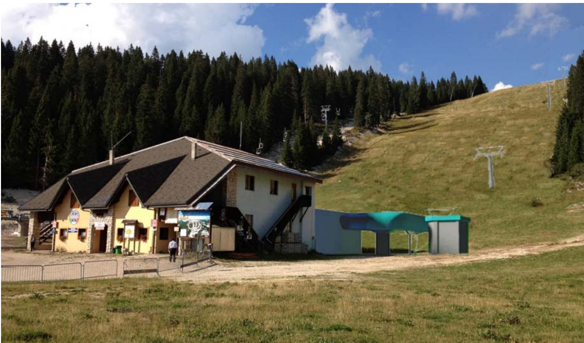
Foto 5.6. CONTESTO INTERMEDIO – Stato di progetto : Visione estiva da sud-est dell'area della stazione di valle e del primo tratto di linea. La posizione ribassata della stele e dei primi due sostegni di ritenuta, conseguente all'intervento di rimodellazione previsto (cfr. Allegato 3), consente di ridurre notevolmente l'impatto visivo dell'opera. La presenza, in adiacenza, del manufatto multifunzionale genera una sorta di continuità strutturale degli elementi, senza intaccare nuove aree verdi. Il manufatto, inoltre, svolge la funzione di scudo visivo nei confronti di chi proviene SSW-WNW, mentre la presenza delle opere resta tangibile per chi si avvicina dalle restanti direzioni. Relativamente alla linea dell'impianto, invece, anche in questo caso si può attribuire una connotazione positiva alle opere, in quanto si riduce la visibilità delle stesse, diradando il numero dei sostegni e delle seggiole.
