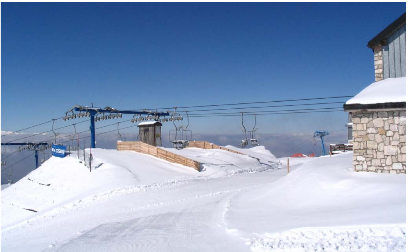
Foto 5.11. CONTESTO RAVVICINATO – Stato di fatto: Visione invernale da nord-est dell'area della stazione di monte.
