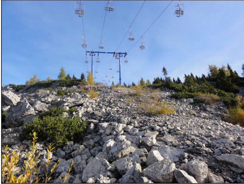
Tratto di 8120 che non verrà interessato dagli interventi
