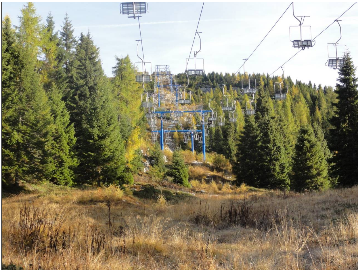
Parte terminale della doppia seggiovia da sostituire
