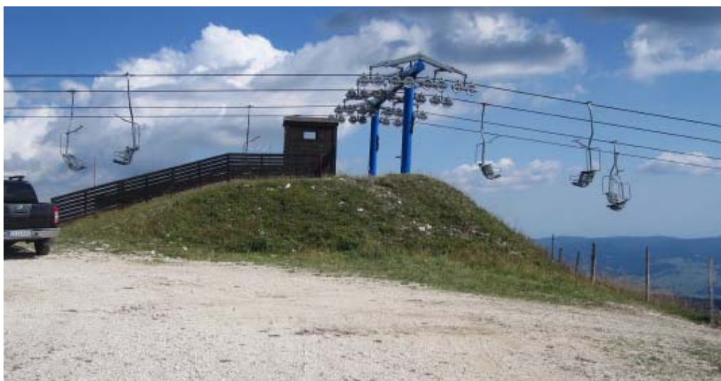
Foto n. 6: Foto di dettaglio sul rilevato artificiale esistente in corrispondenza della stazione di monte di progetto. La realizzazione della nuova seggiovia ne prevede la rimozione e l'inserimento della stazione di motrice di monte con locale seminterrato sottostante.
