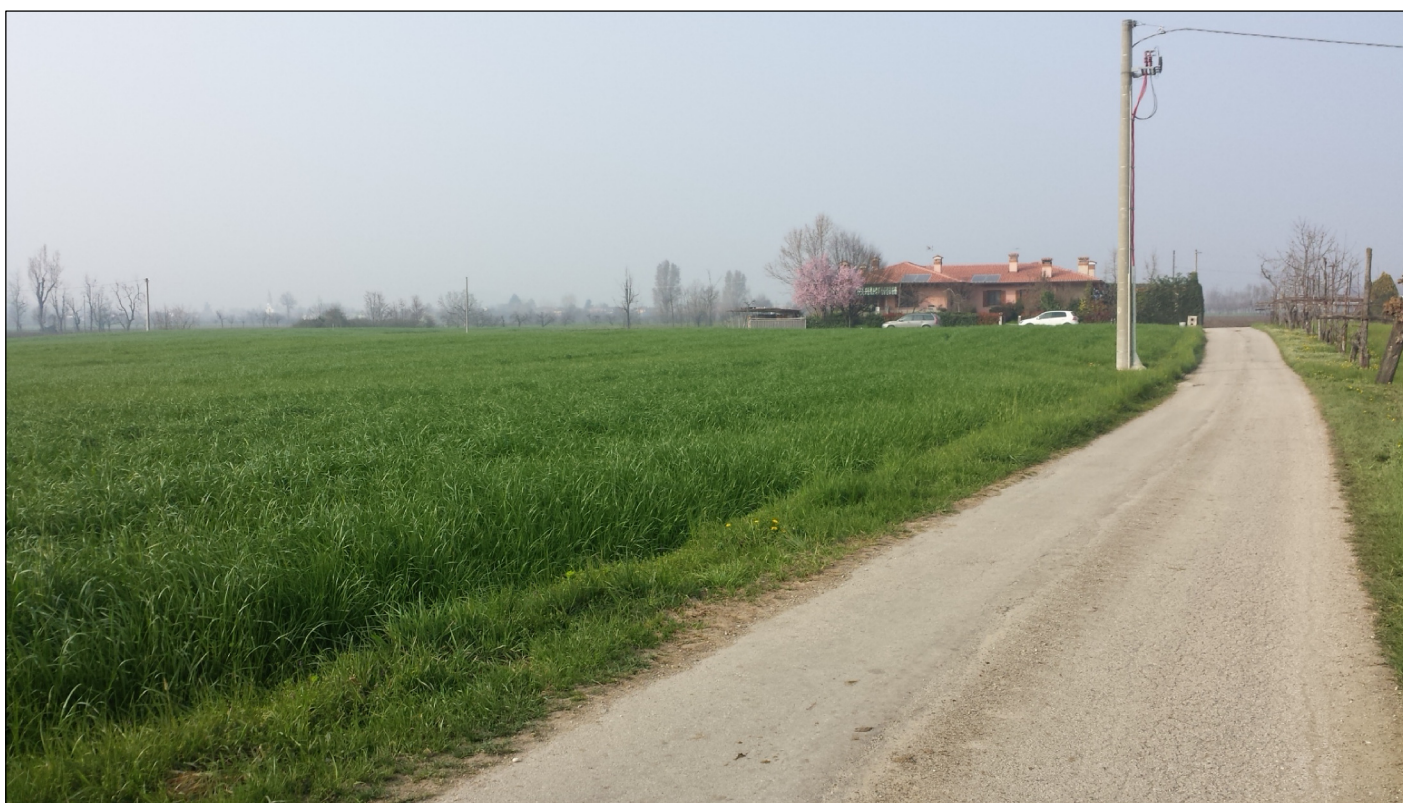
FOTO - 4 - FOTO DEI LOTTI E DEL FABBRICATO RES.LE DI PROPRIETA' DALLA STRADA DI ACCESSO AD EST
