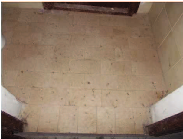
2- PAVIMENTO PIASTRELLE IN CERAMICA
