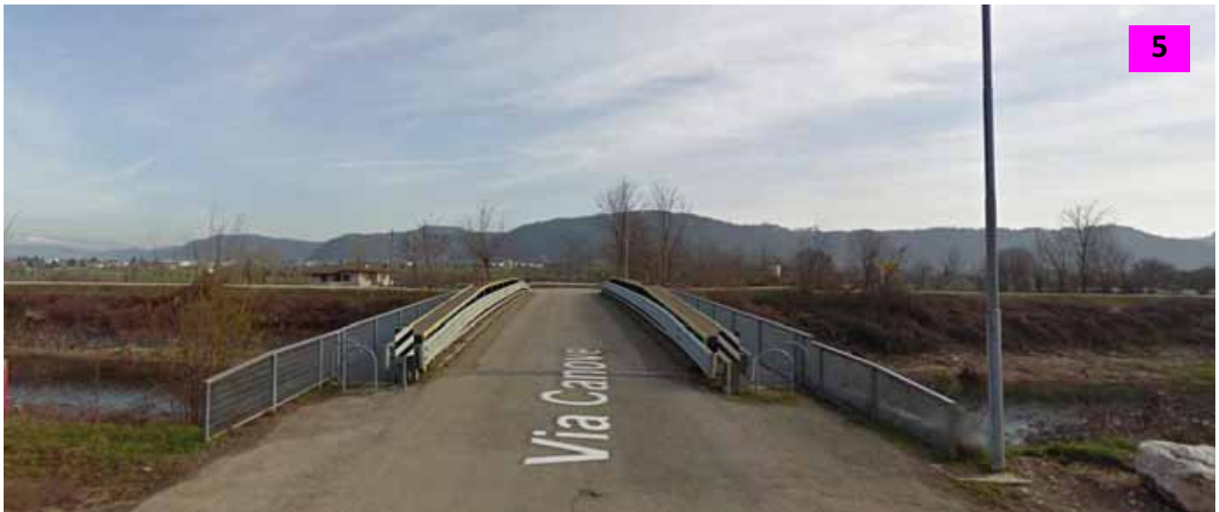
Foto 5: Via Canove, in prossimità del ponte sul fiume Guà.
