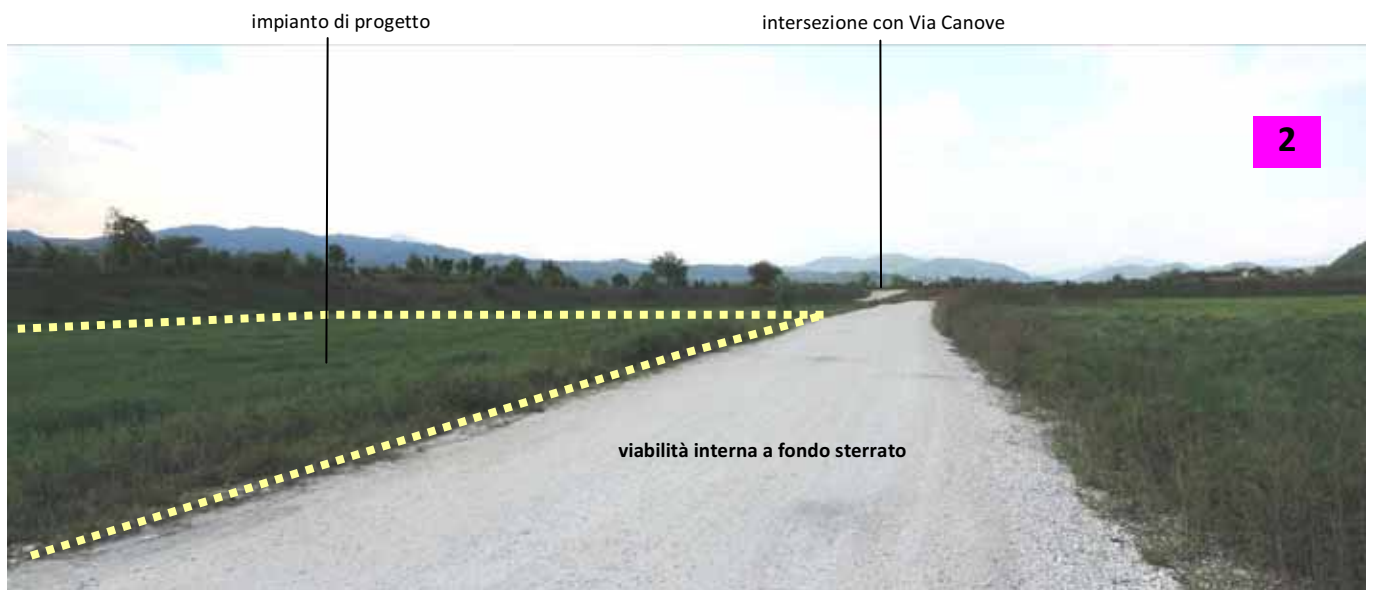
Foto 2: viabilità interna e ubicazione dell'impianto di progetto (linea tratteggiata).
