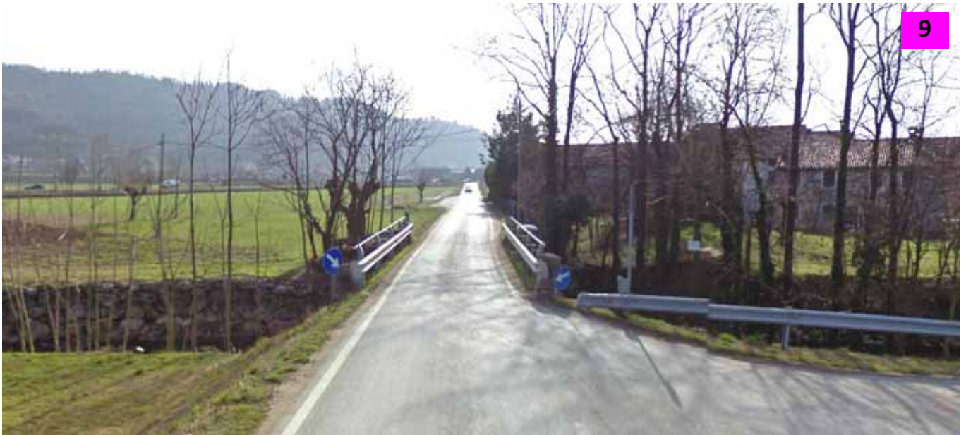
Foto 9: Via Canove in prossimità del ponte sul torrente Poscola (direzione SP 246).
