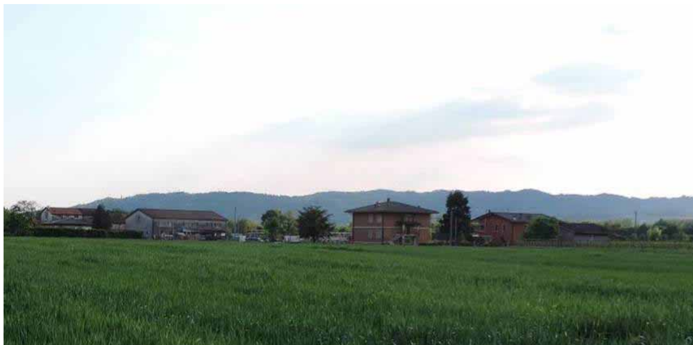
Figura 78: interventi edilizi all'interno dell'ambito agricolo di via Canove realizzati negli ultimi decenni.
