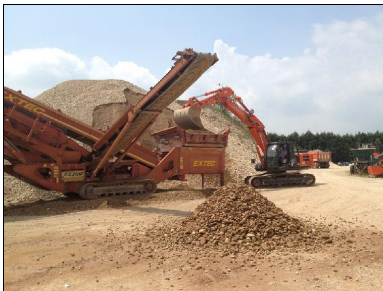
Foto n.2: Vaglio ed escavatore in fase di vagliatura (simulazione operazione)
