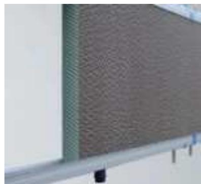
l'acqua e ne cede il calore, raffrescandosi. L'acqua, non evaporata per il passaggio di calore e che quindi non viene consumata nel processo di raffrescamento, viene fatta circolare nuovamente nel pannello grazie al sistema di ricircolo a pompe, limitandone così gli sprechi.
