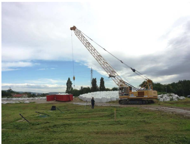
Figura 40- – Foto della drag line di Pulistrade in discarica n.7 durante il collocamento dei big-bags
