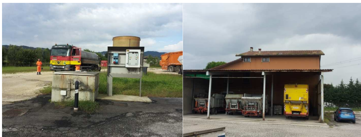
Figura 39- - Fotografie della centralina di controllo dei pozzi percolato e della palazzina ex Filippozzi
