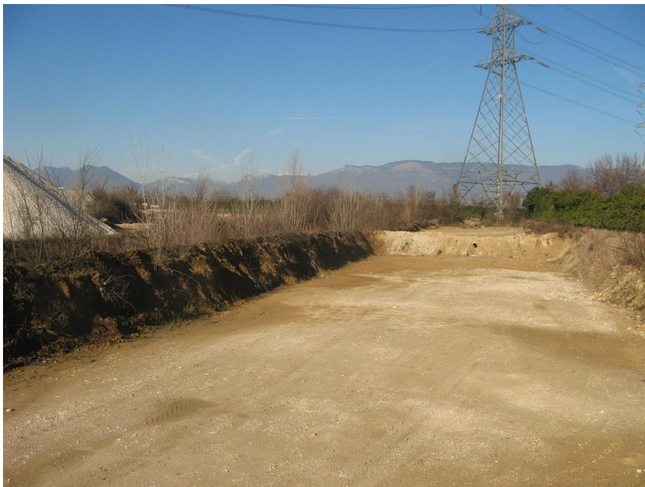
Figura 8 : vasca di essiccazione fanghi che percorre il confine est del cantiere. A destra è possibile notare la siepe che delimita il sito su tre lati.
