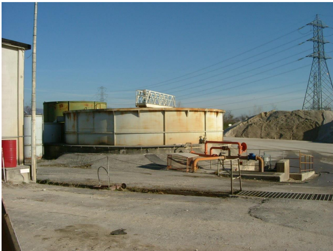
Figura 3 : impianto di chiarificazione delle acque con particolare della griglia di raccolta.
