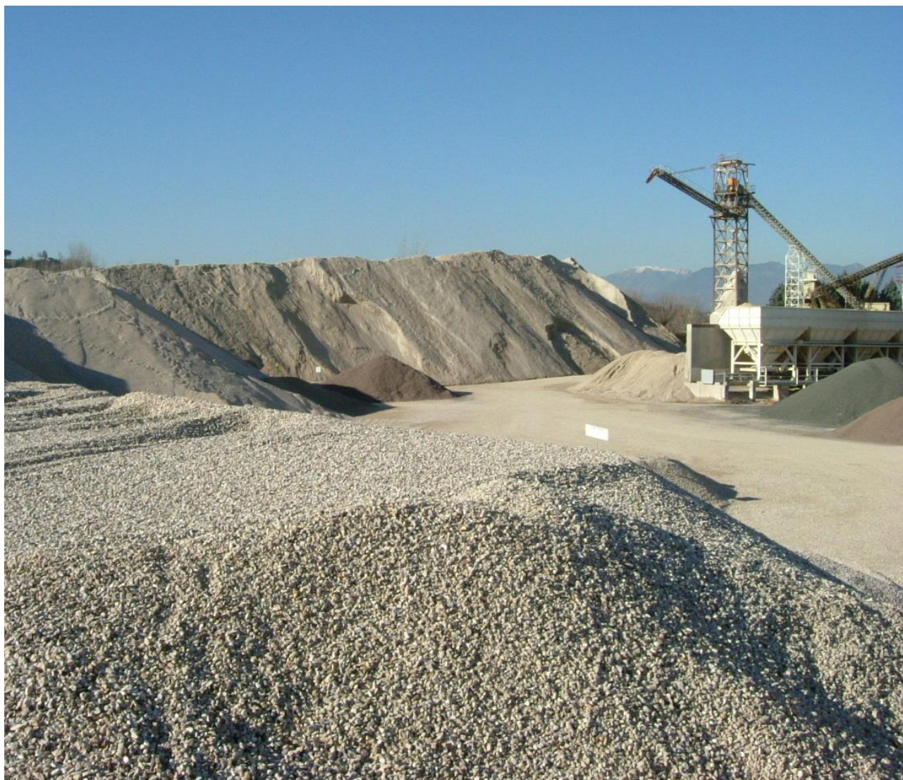
Figura 6 : cumuli di materiale inerte presenti al confine sud del cantiere.
