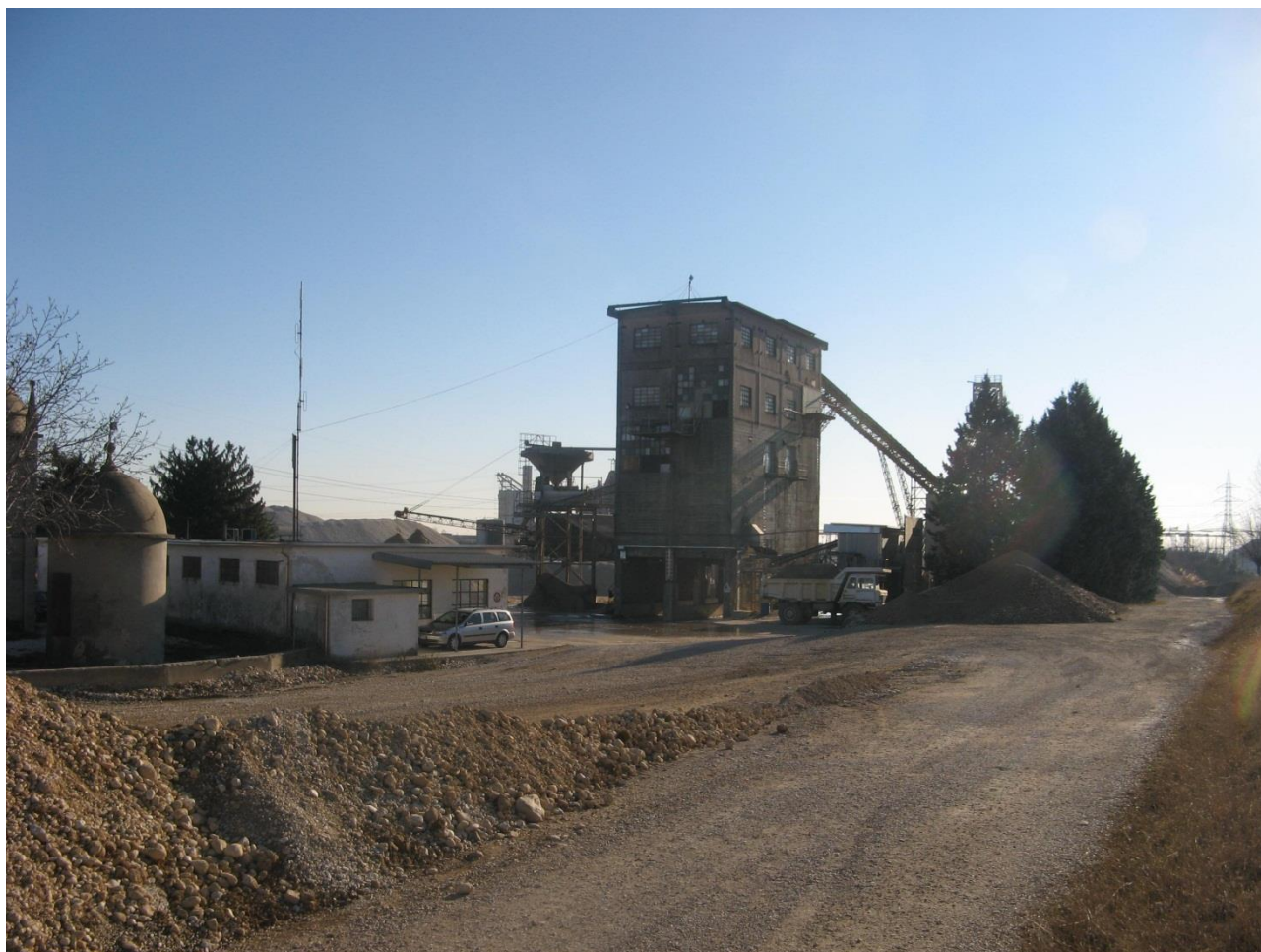
Figura 2 : impianto per lavorazione inerti, lato nord. Sulla sinistra si notano l'edificio ove vengono espletate le operazioni di accettazione del rifiuto CER 17 03 02.
