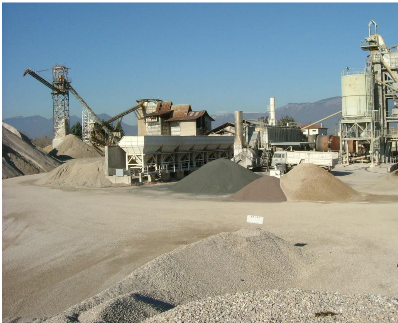
Figura 4 : particolare dei predosatori contenenti materiale di diversa granulometria per il confezionamento del conglomerato bituminoso.
