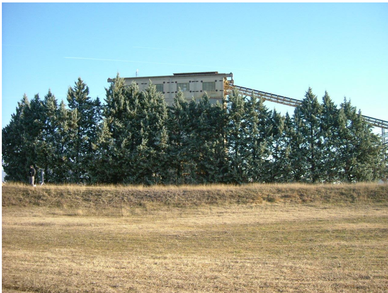
Figura 1 : impianto per lavorazione inerti, lato ovest.
