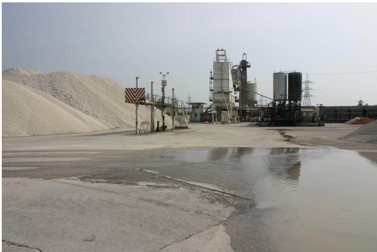
Figura 9 : impianto di confezionamento del conglomerato bituminoso. Si notano sulla destra i silos per lo stoccaggio del bitume.
