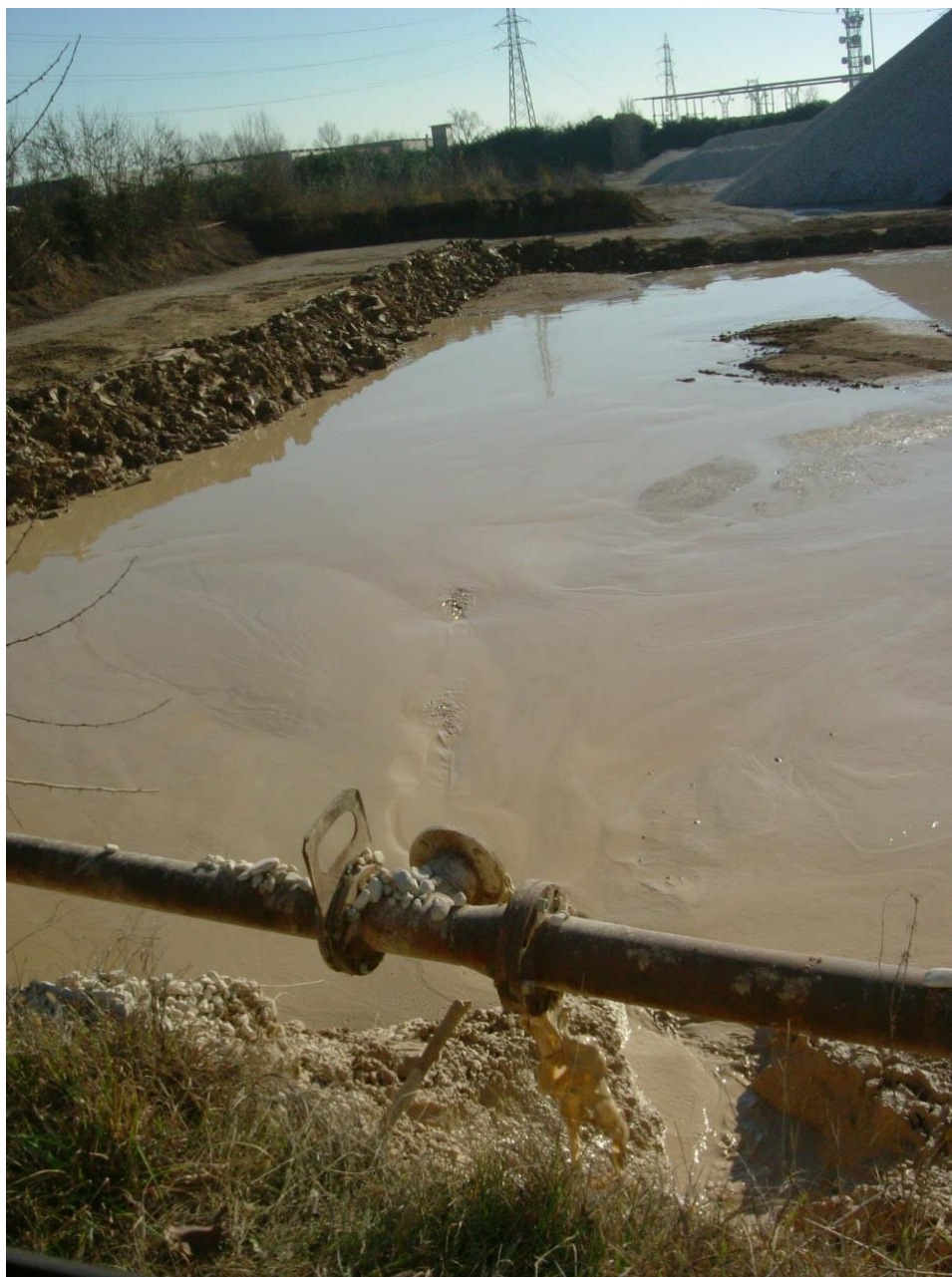
Figura 7 : vasca di essiccazione fanghi nei pressi del confine nord.
