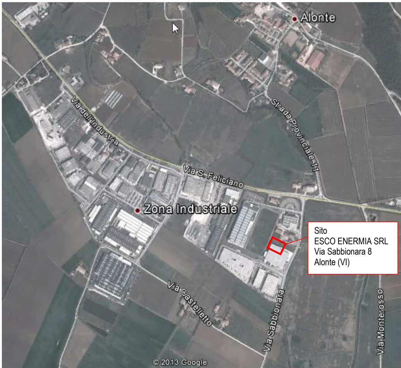
Figura 1: Vista aerea dell'area di nuova lottizzazione
