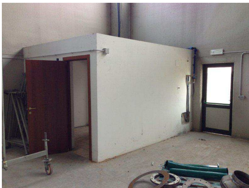
Figura 6: Servizi (in allestimento)
