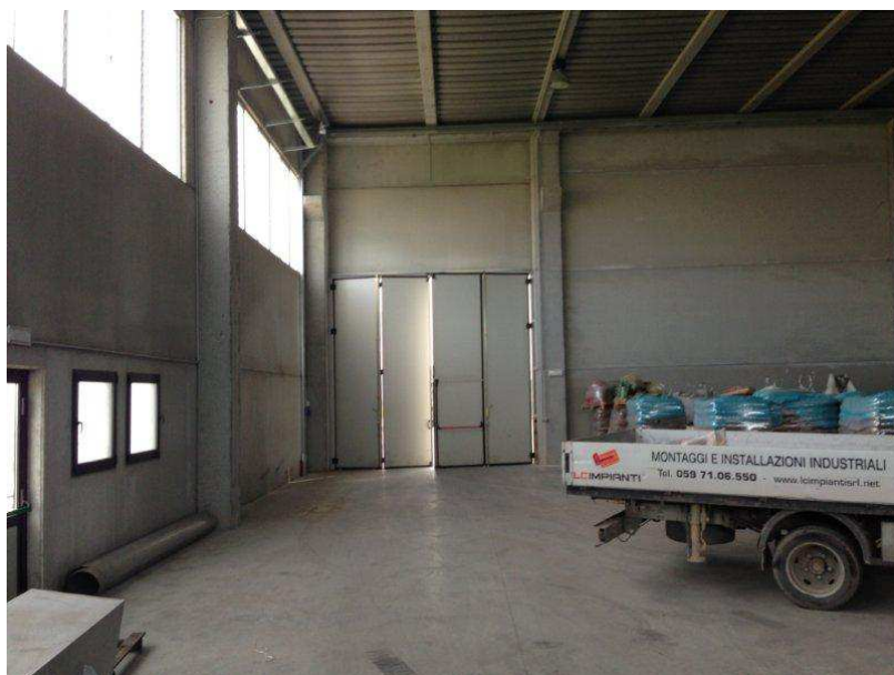
Figura 4: vista ingresso da interno stabilimento
