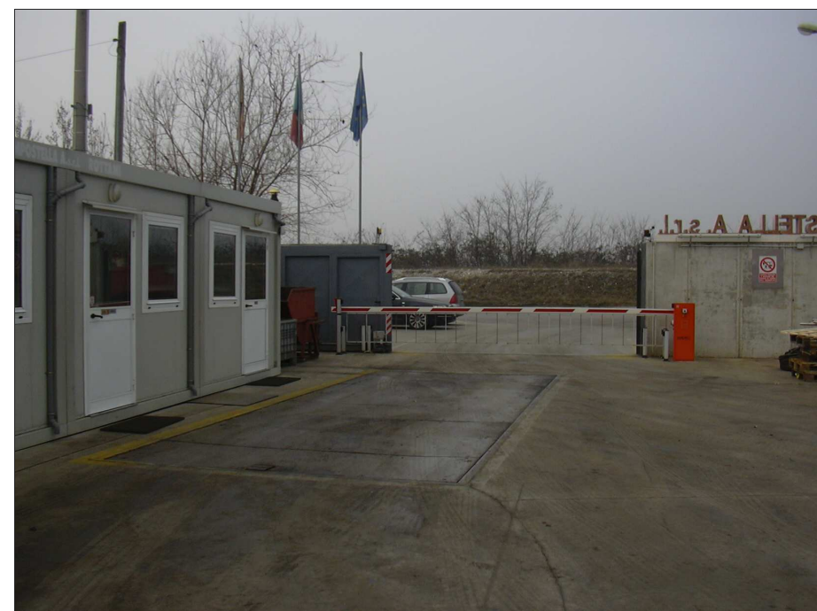
FOTO N° 1 AREA DI ACCETTAZIONE E PESATURA
