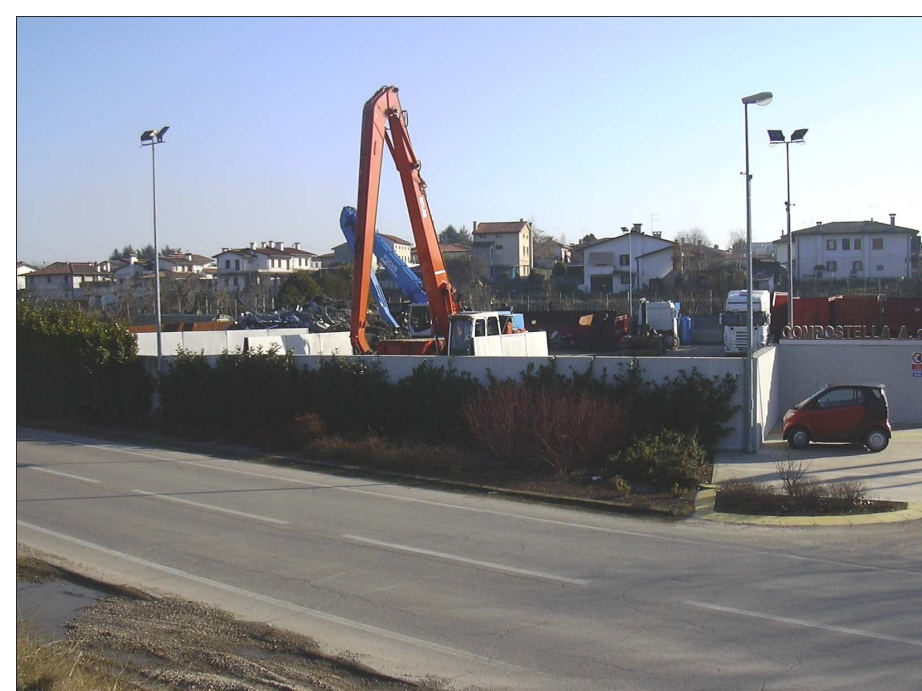
FOTO N° 3 LATO ESTERNO FRONTE STRADA
