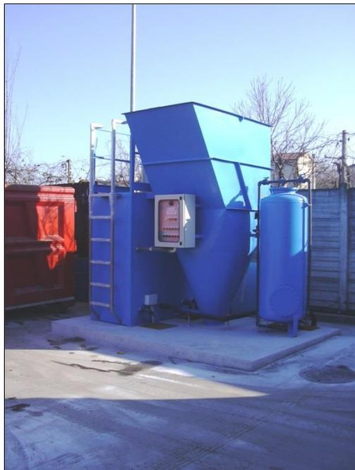
**Figura 5: Impianto di trattamento chimico-fisico**
