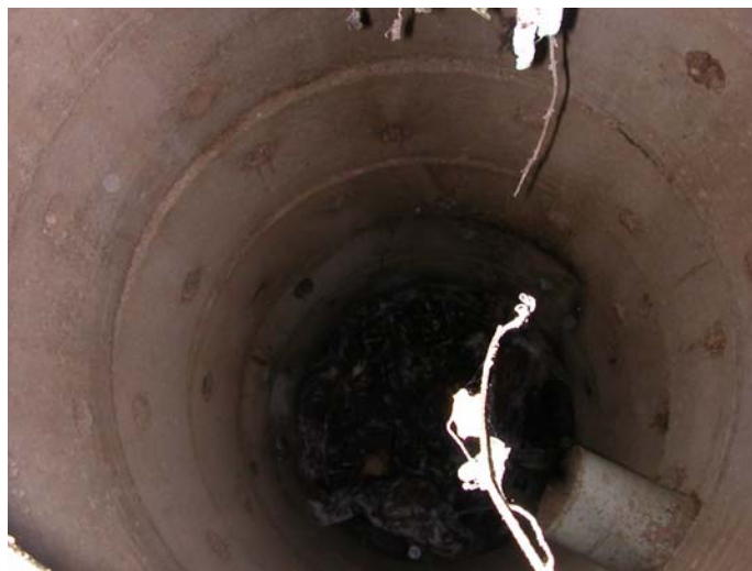
Vista dell'interno del pozzo perdente, con al fondo depositati sacchi neri e vista di un tubo di adduzione
