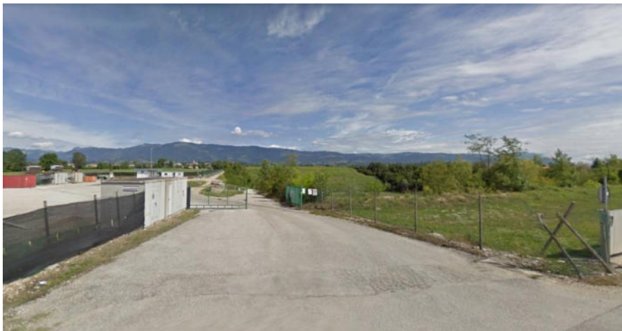
Figura 35 – Ingresso da Via Molle all'area "Quartieri". Sulla sinistra gli impianti CO.RSEA. per trattamento e combustione biogas.
