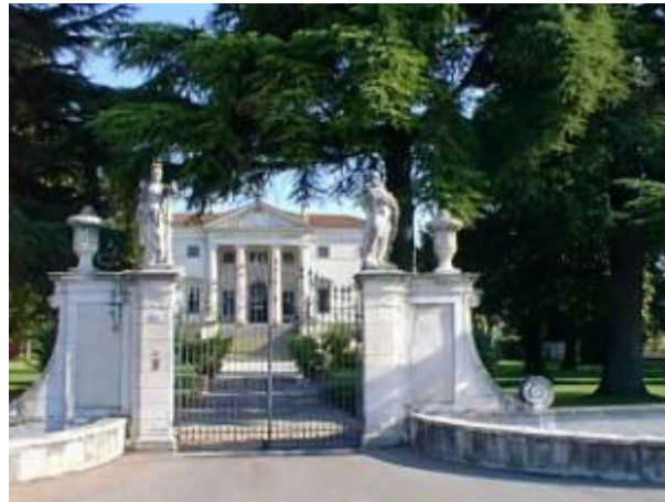
Figura 7 – Panoramica Villa Capra Bassani
