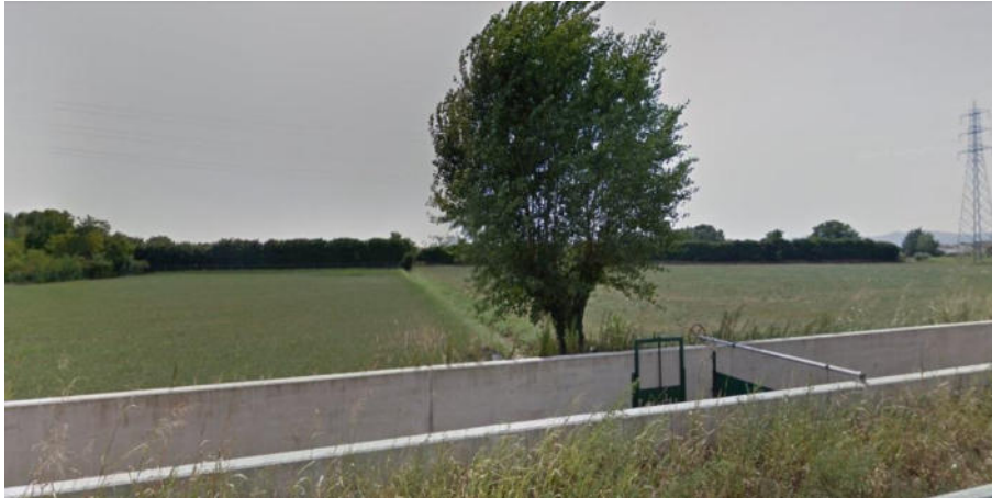
Figura 31 – Sopra: Panoramica dell'area "Quartieri" con ubicazione cono visuale su via Molle (rosso) e su Via Salbega (giallo); A metà: visuale da Via Molle del ciglio di cava. L'area interna di cantiere non è visibile. Sotto: visuale sulla siepe settentrionale della discarica dalla strada a nord. L'area di discarica non è visibile dall'esterno. Fonte dei dati: Google maps (2019)
