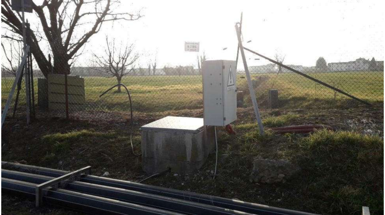
Foto 13: vista del pozzo piezometrico di controllo n. 2 bis a valle, sul lato ovest della discarica, vicino alle condotte del biogas.
