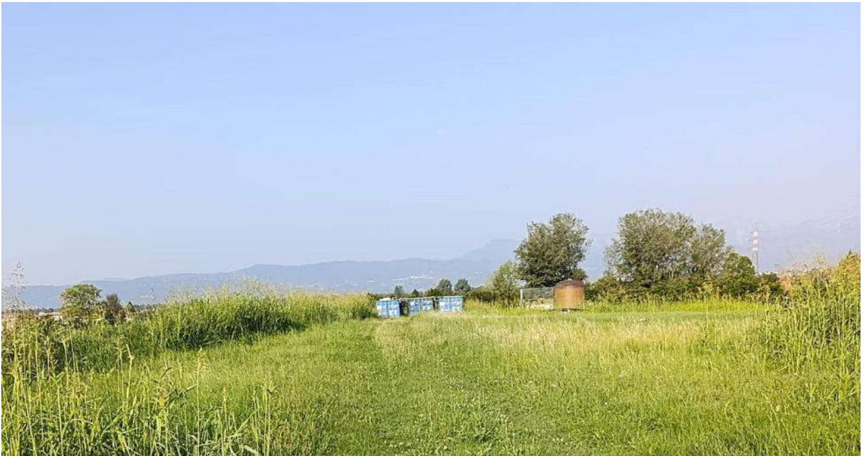
Foto 2: Vista della zona impianti sulla sommità discarica;
