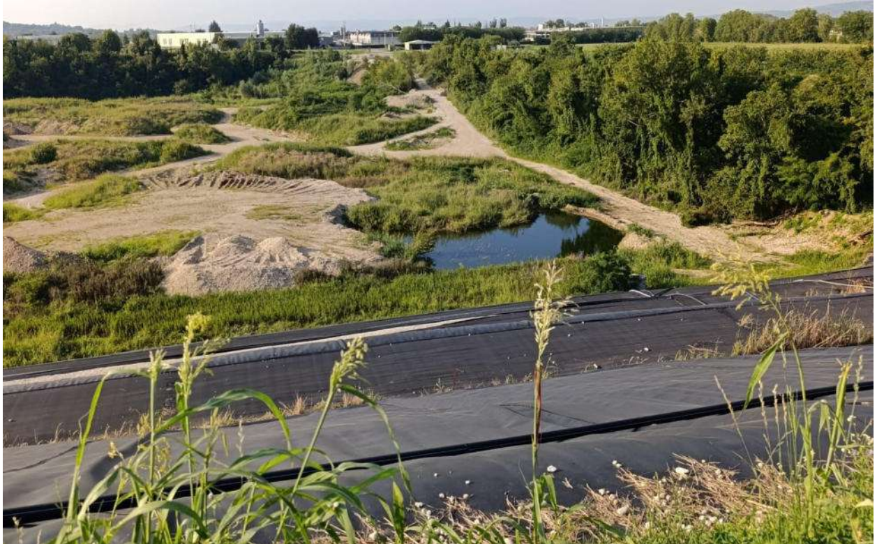
Foto 9: vista dalla sommità discarica della scarpata sud e del piano di cava verso sud-est, con la strada di accesso al fondo cava. In primo piano il telo HDPE di sicurezza della scarpata.
