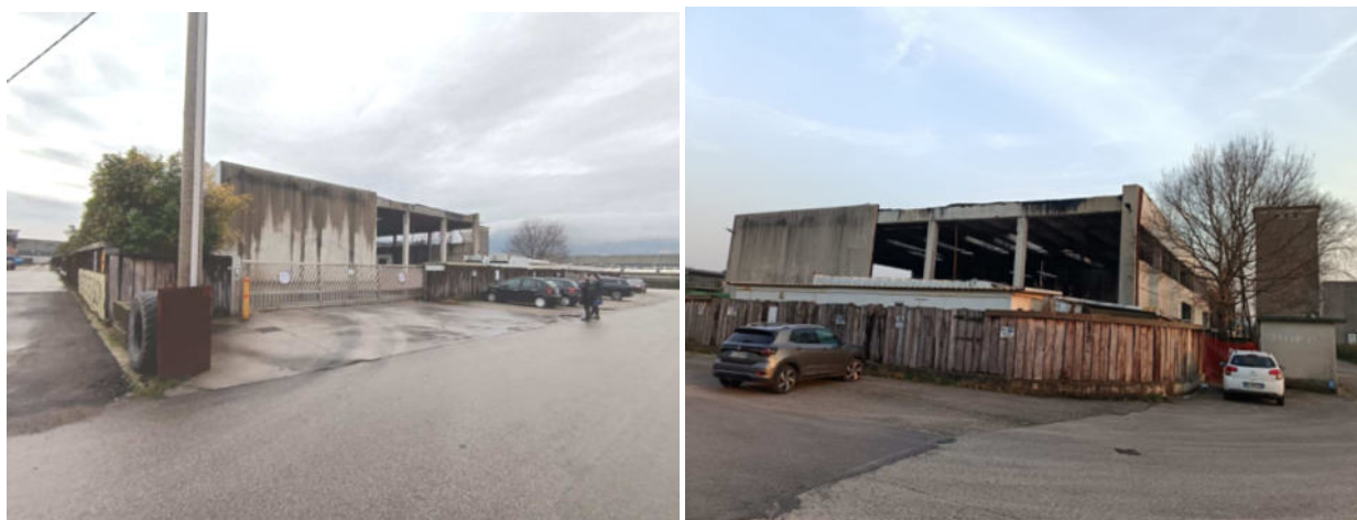
Vista capannone C stato di fatto
