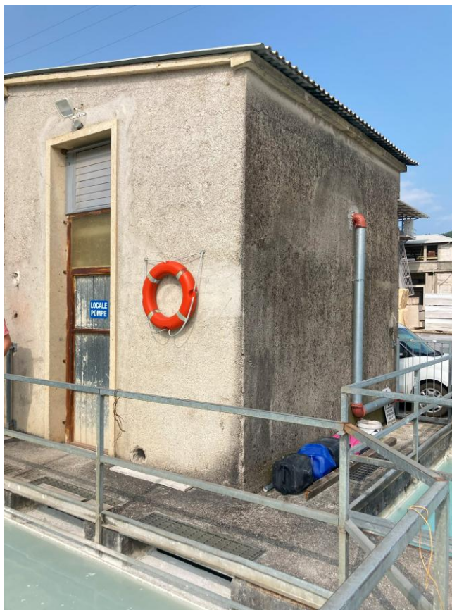
Figura 6 Il locale pompe che rilanciano allo stabilimento l'acqua chiarificata
