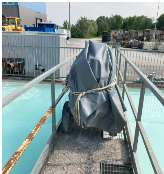
Figura 5 La settima vasca a cielo aperto, qui l'acqua ha subito per successive decantazioni il processo di chiarificazione. A sinistra l'edificio con la vasca interrata
