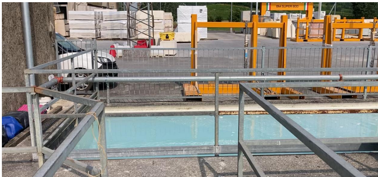
Figura 5 La settima vasca a cielo aperto, qui l'acqua ha subito per successive decantazioni il processo di chiarificazione. A sinistra l'edificio con la vasca interrata
