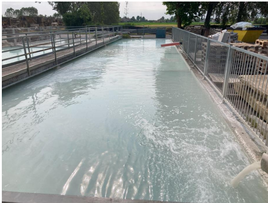
Figura 10 Le vasche di decantazione, in primo piano le tre vasche a sud, a destra si osservano i due punti di ingresso dei reflui provenienti dallo stabilimento (tubi bianco campata ovest dello stabilimento, tubo giallo campata est dello stabilimento). A sinistra le ulteriori tre vasche di decantazione
