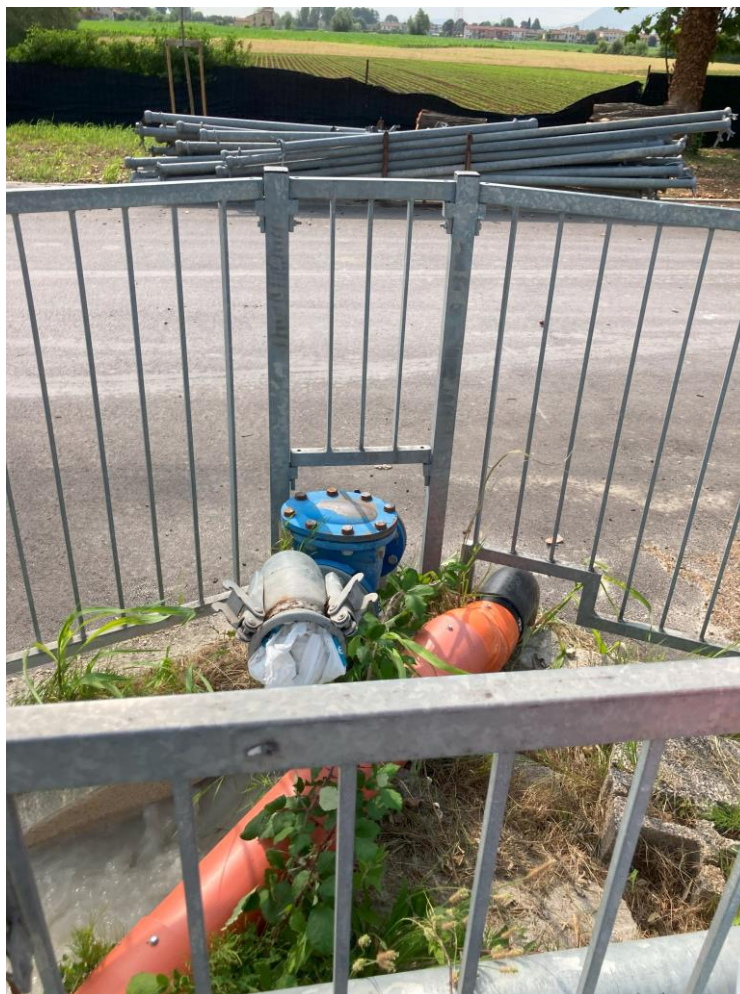
Figura 14 - Il punto di rilancio dei fanghi dalle vasche alla discarica, da qui le tubazioni corrono interrate
