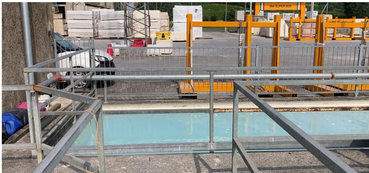
Figura 12 La settima vasca a cielo aperto, qui l'acqua ha subito per successive decantazioni il processo di chiarificazione. A sinistra l'edificio con la vasca interrata
