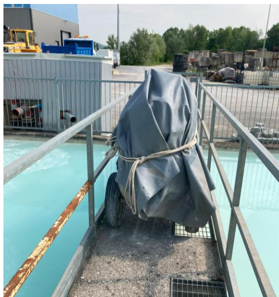
Figura 12 La settima vasca a cielo aperto, qui l'acqua ha subito per successive decantazioni il processo di chiarificazione. A sinistra l'edificio con la vasca interrata
