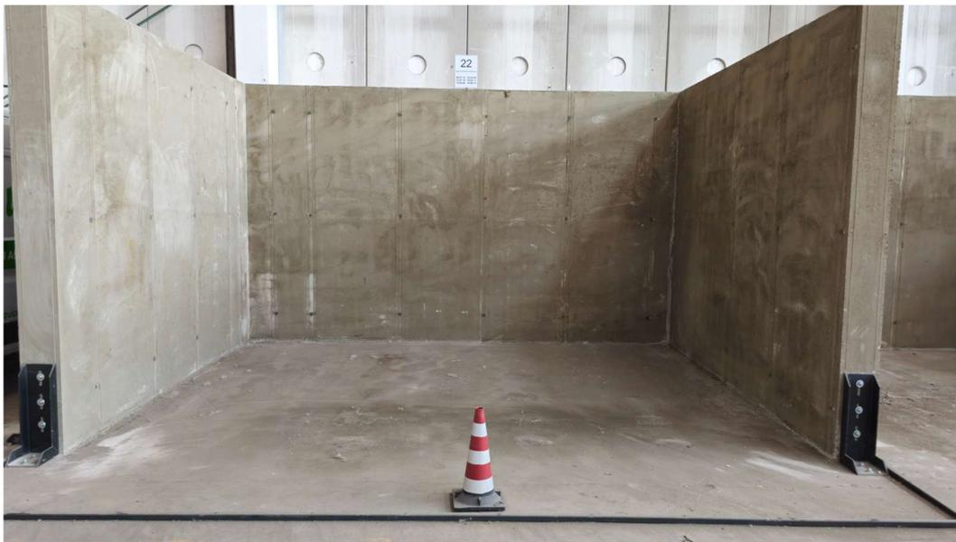
Figura 6. Stoccaggi realizzati per i fanghi in big-bags; si noti la presenza di un cordolo di contenimento di eventuali colaticci residui
