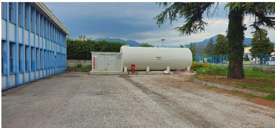
Figura 4. Cisterna per la riserva idrica antincendio realizzata nel piazzale est
