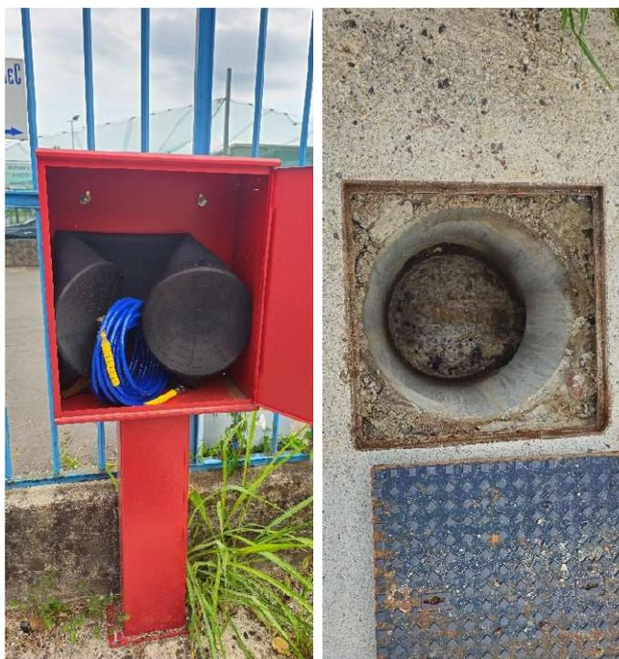
Figura 2. Pozzetto e relativo pallone otturatore gonfiabili installato al posto della valvola manuale allo scarico in fognatura nei pressi dell'ingresso dell'impianto
