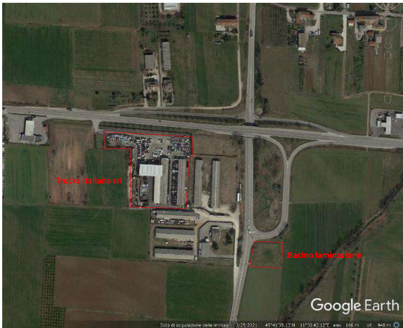
Figura 2 - Foto aerea dell'area - ditta Trucks Italiana srl (fonte: Google Earth)
