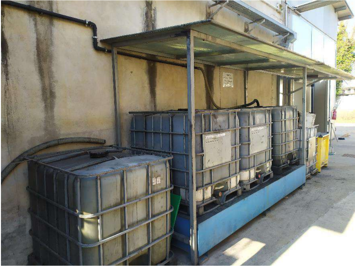
Foto 17. Stoccaggio rifiuti liquidi (si precisa che la cisterna al di fuori della tettoia è vuota e di scorta)
