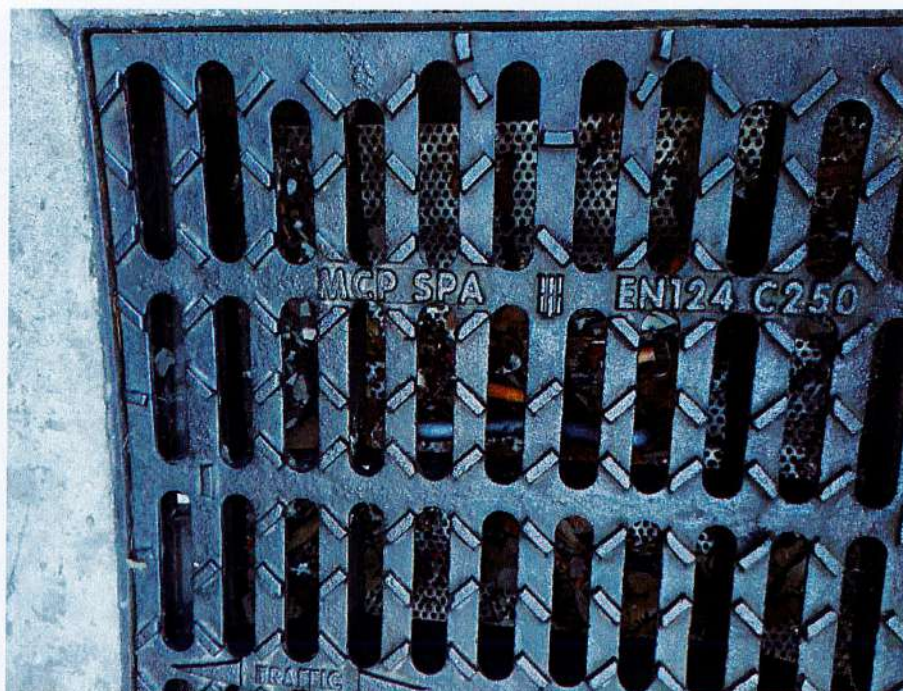
Figura 6. Caditoia con sistema di grigliatura
