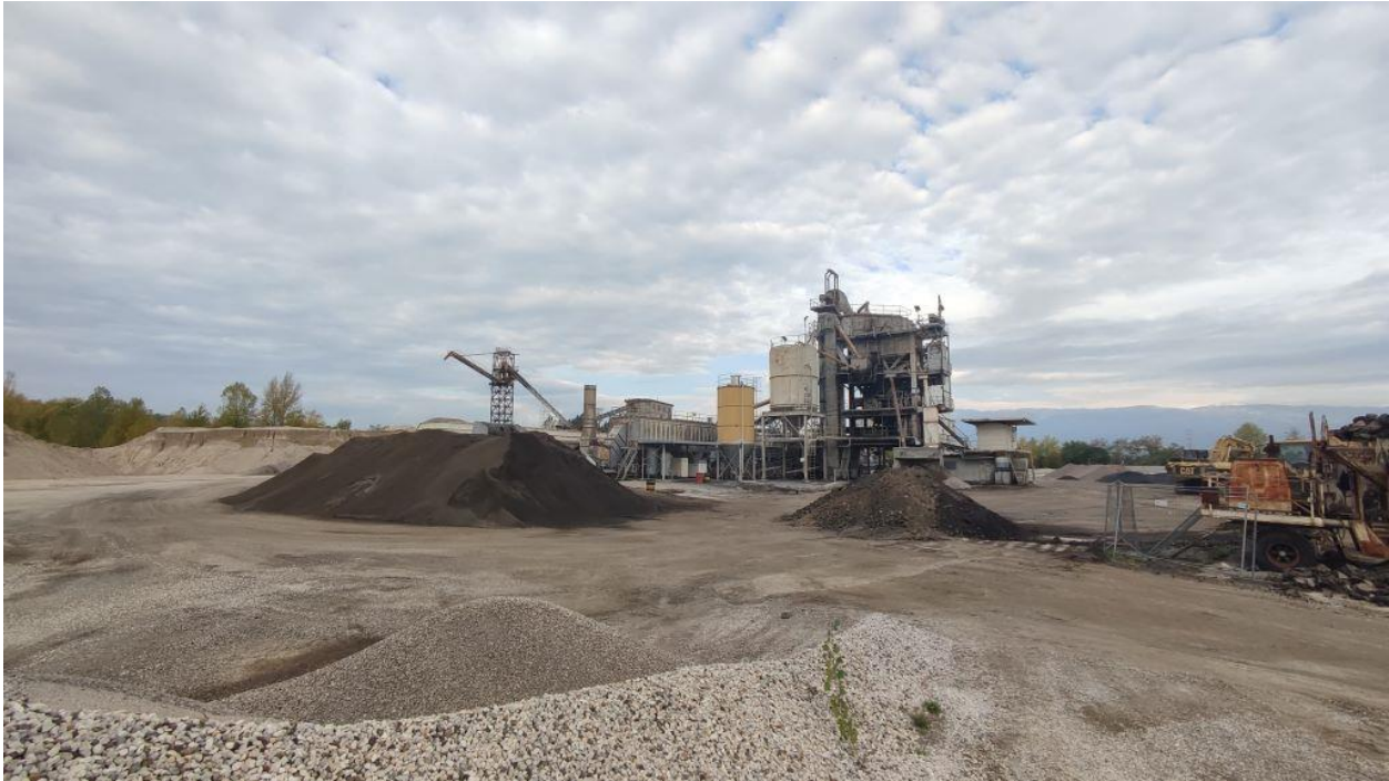
Foto 12 Panoramica degli impianti di bitumaggio e recupero visti da sud; a sinistra è visibile la recinzione dell'Area B di recupero mentre al centro vi sono lotti di granulato già caratterizzati e pronti all'utilizzo o alla vendita.
