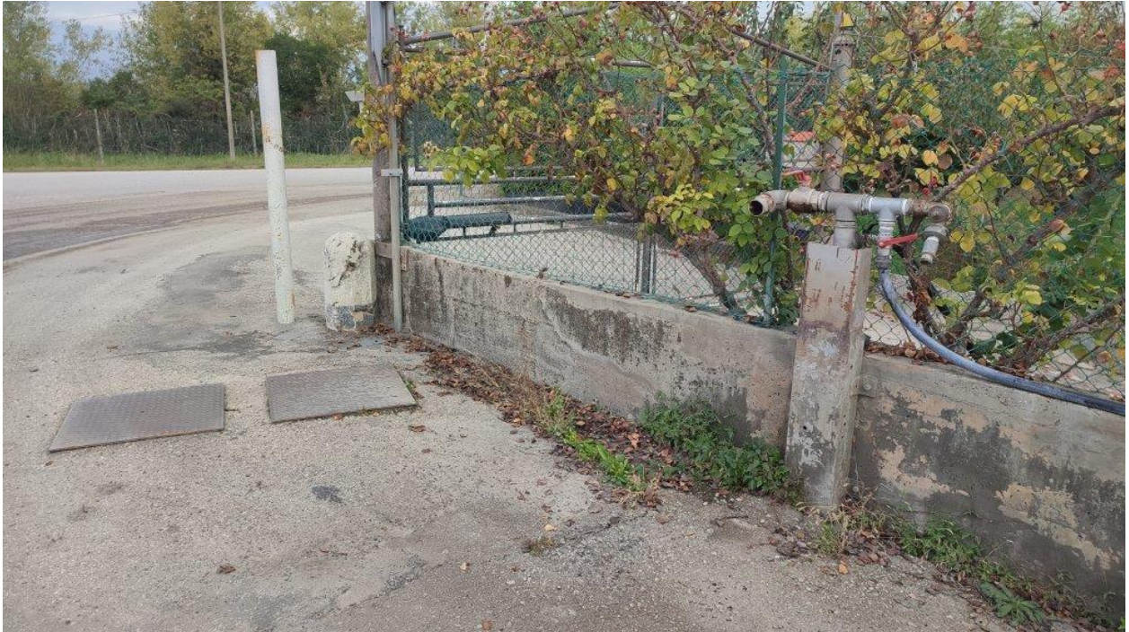
Foto 16 – Vista Pozzo di Monte, che è il pozzo industriale in concessione a SIG SpA, presso l'ingresso dell'area; è visibile la colonnina con le prese per l'impianto (bagnatura strade) e la presa per i campionamenti del Programma di controllo dell'impianto B TECH
