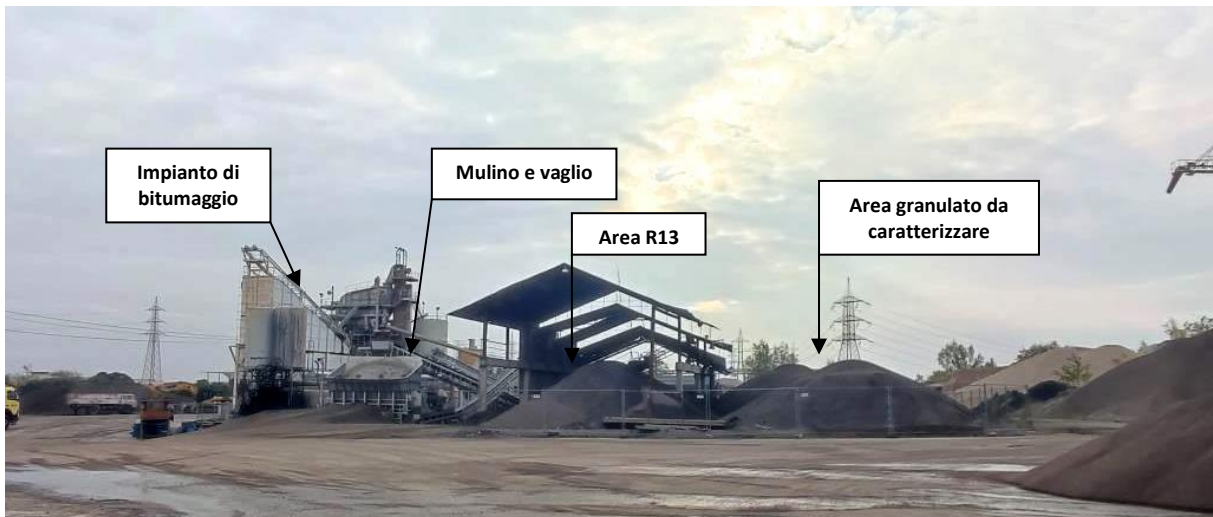
Foto 2 - Panoramica dell'impianto B TECH (Area A) da nord, dall'ingresso su Via Astico
