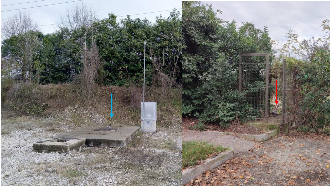
Foto 14 – Vasca interrata in cemento delle acque di prima pioggia (freccia azzurra) posta ad est dell'impianto, a destra, e della recinzione di protezione del manufatto di allaccio alla fognatura, con il pozzetto fiscale PF2 (freccia rossa)
