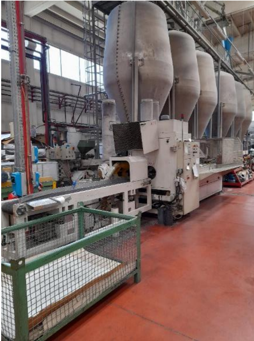
Foto 15. Area impianto per produzione tubi
