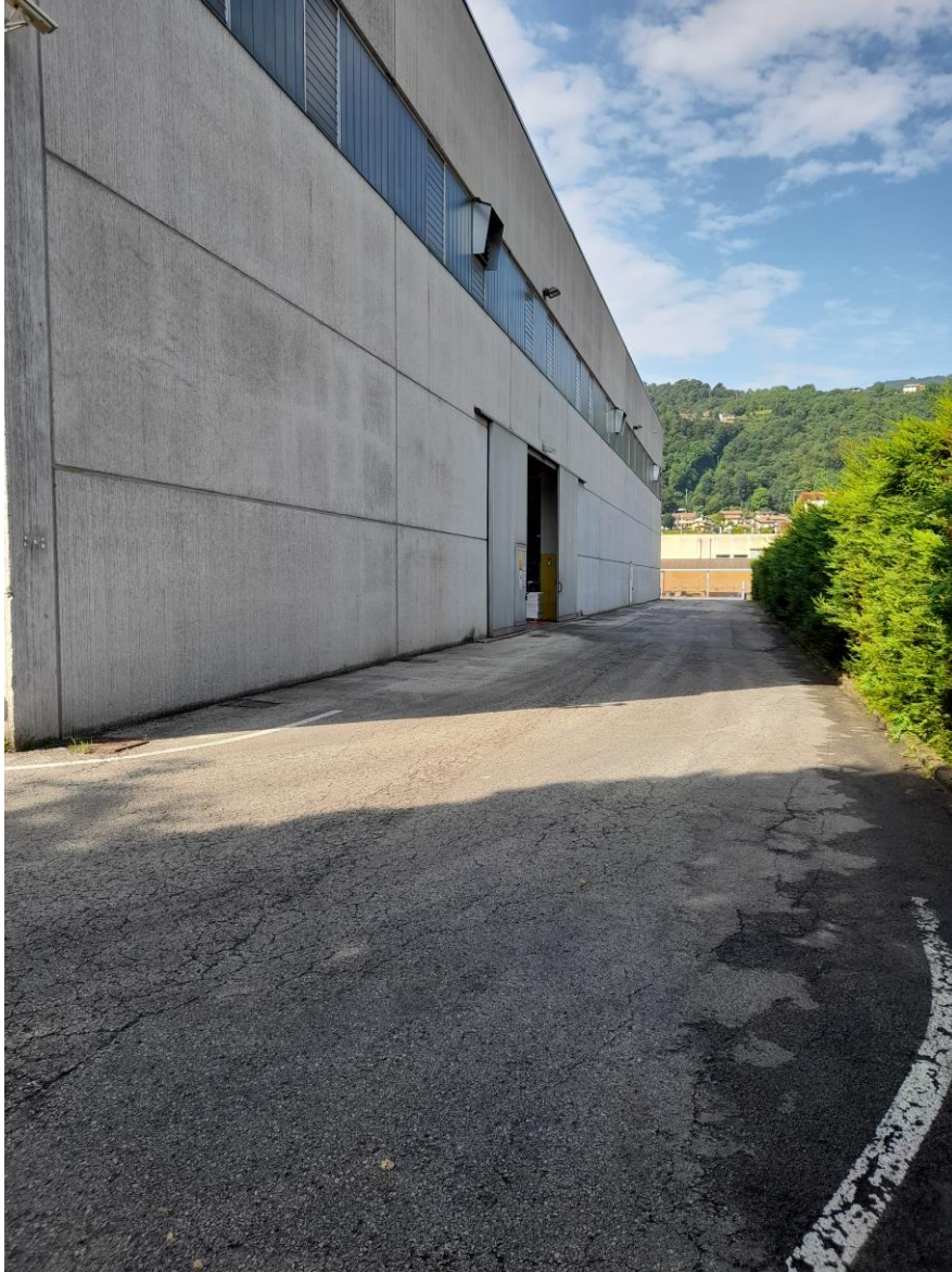
Foto 41. Area esterna lato sud
