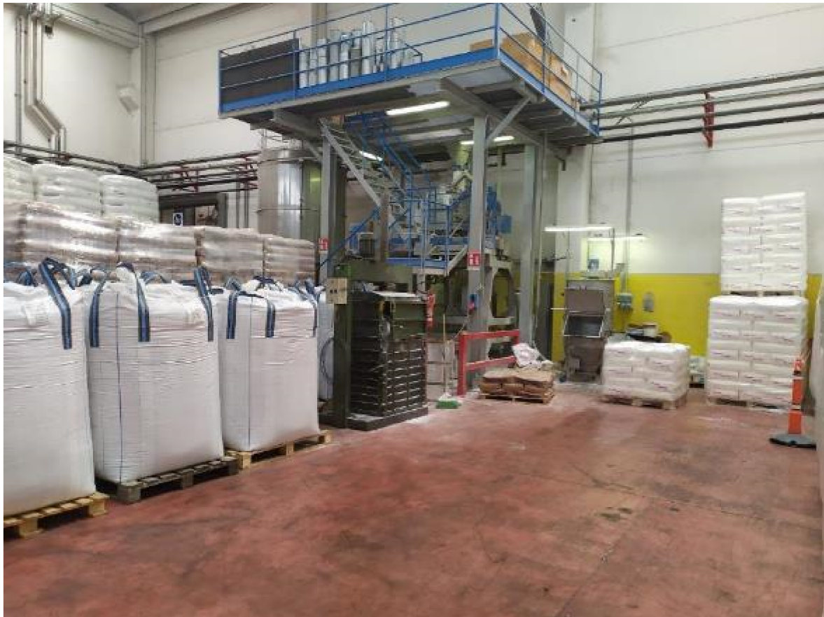
Foto 3. Aree stoccaggio materie prime (A1 a sinistra e A5 a destra); sullo sfondo alimentazione estrusori PVC
