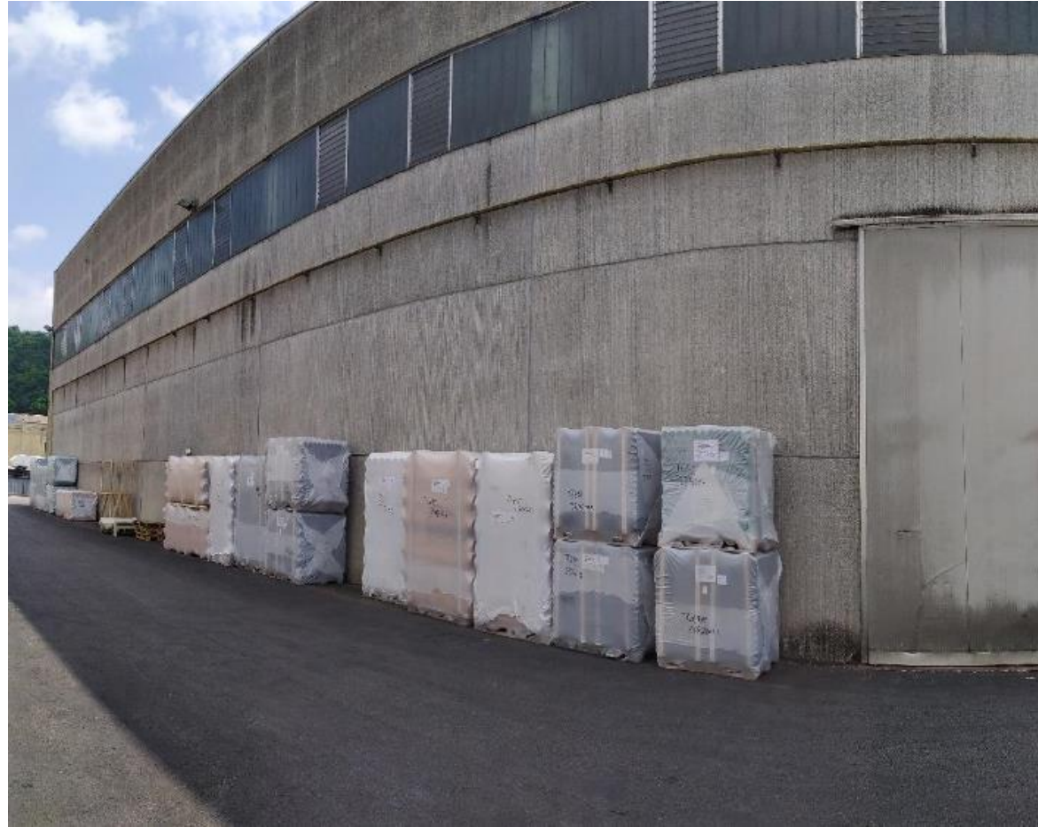
Foto 40. Panoramica deposito prodotti finiti (tubi)
