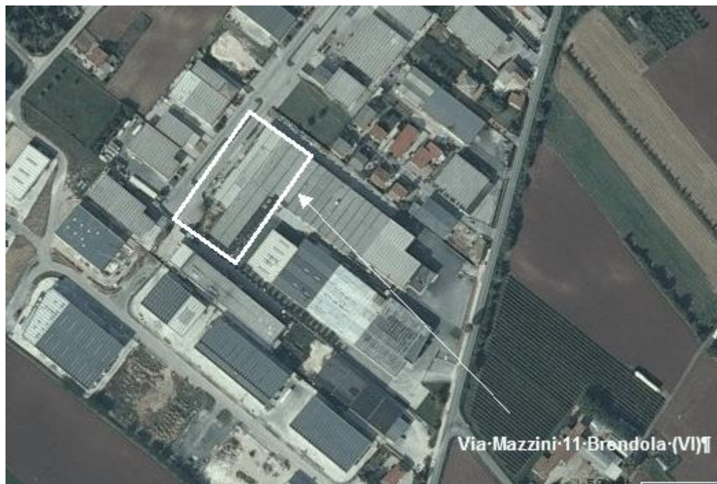
Figura 3: vista aerea dello stabilimento e delle aree circostanti
