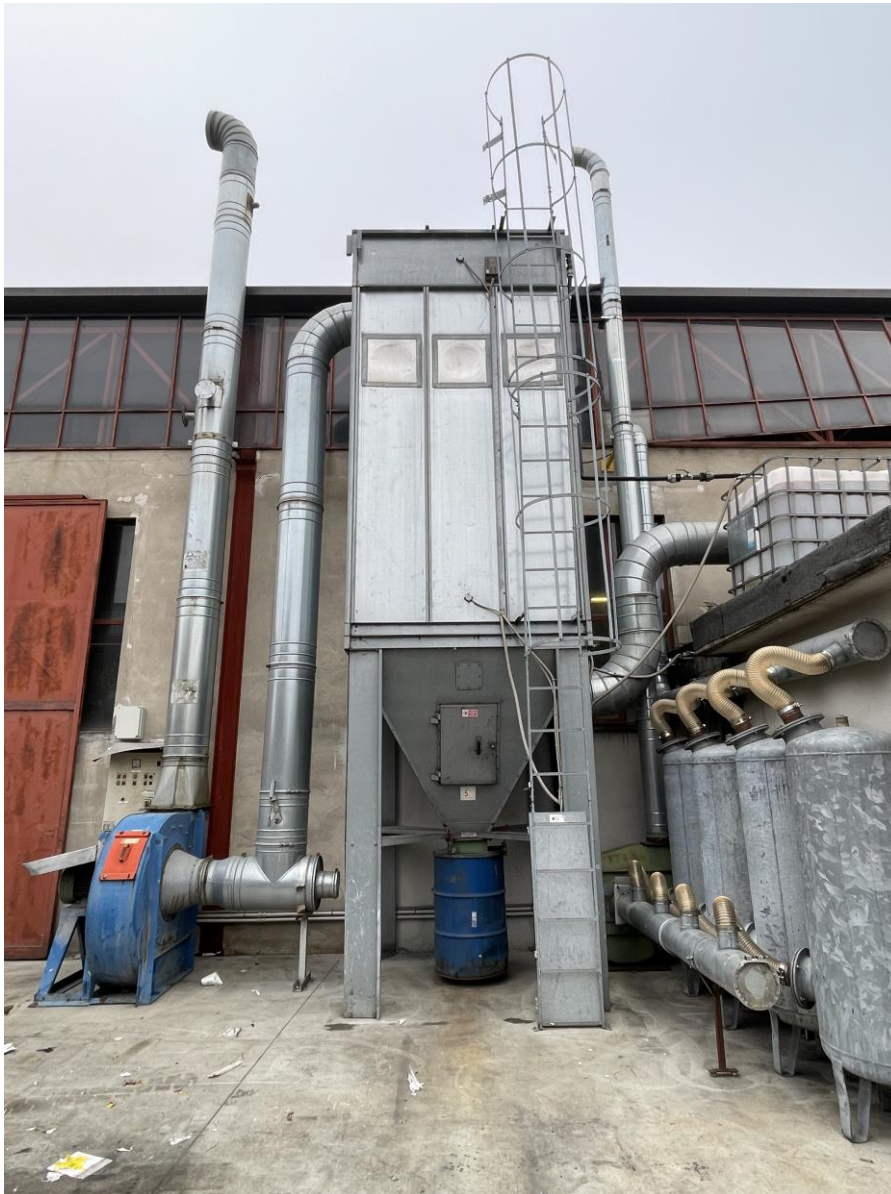
Figura 1: camino 1 (a destra) e camino 2 (a sinistra).
