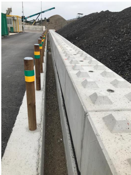
Figura 9 - canaletta di raccolta acque meteoriche
