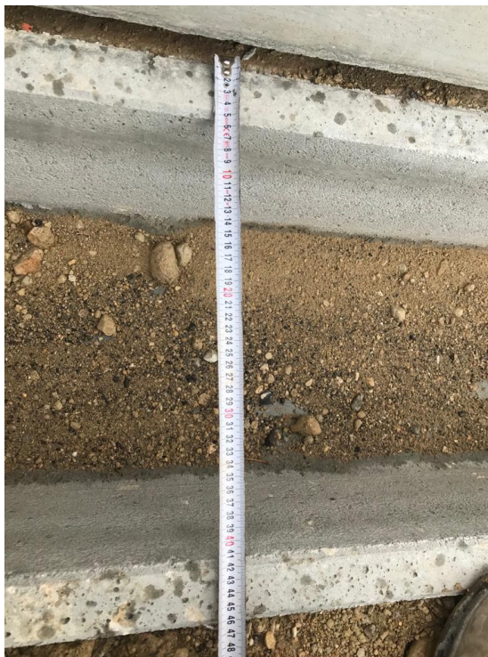
Figura 7 - canaletta di raccolta acque meteoriche
