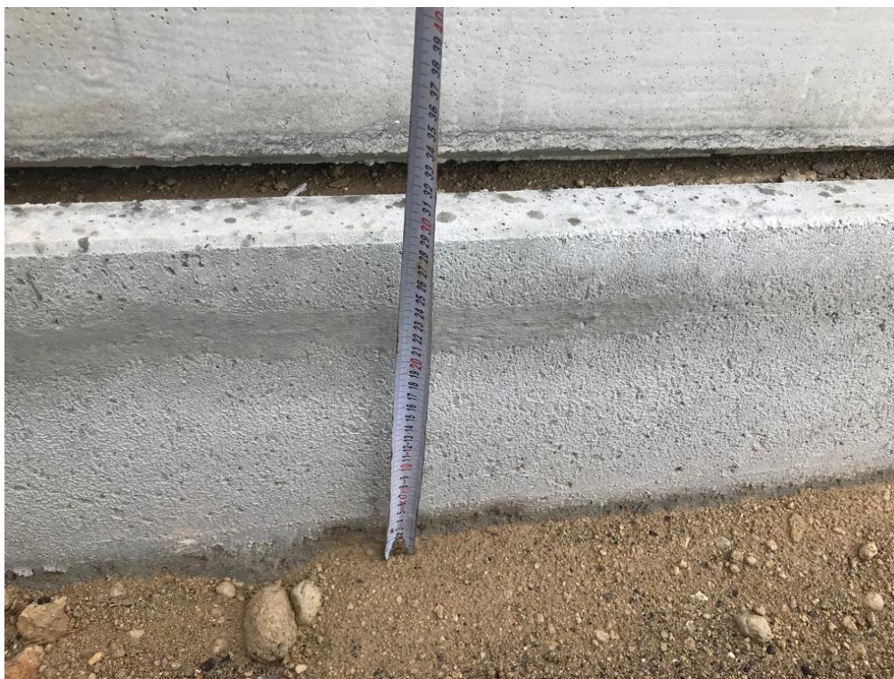
Figura 8 - canaletta di raccolta acque meteoriche
