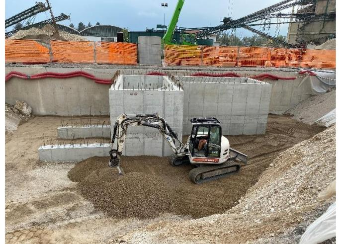
La vasca è stata coperta con delle solette rimovibili, munite di passo d'uomo e scala fissa per un facile accesso all'interno e per l'agevolato accesso alle elettropompe in caso di avaria/manutenzione.
