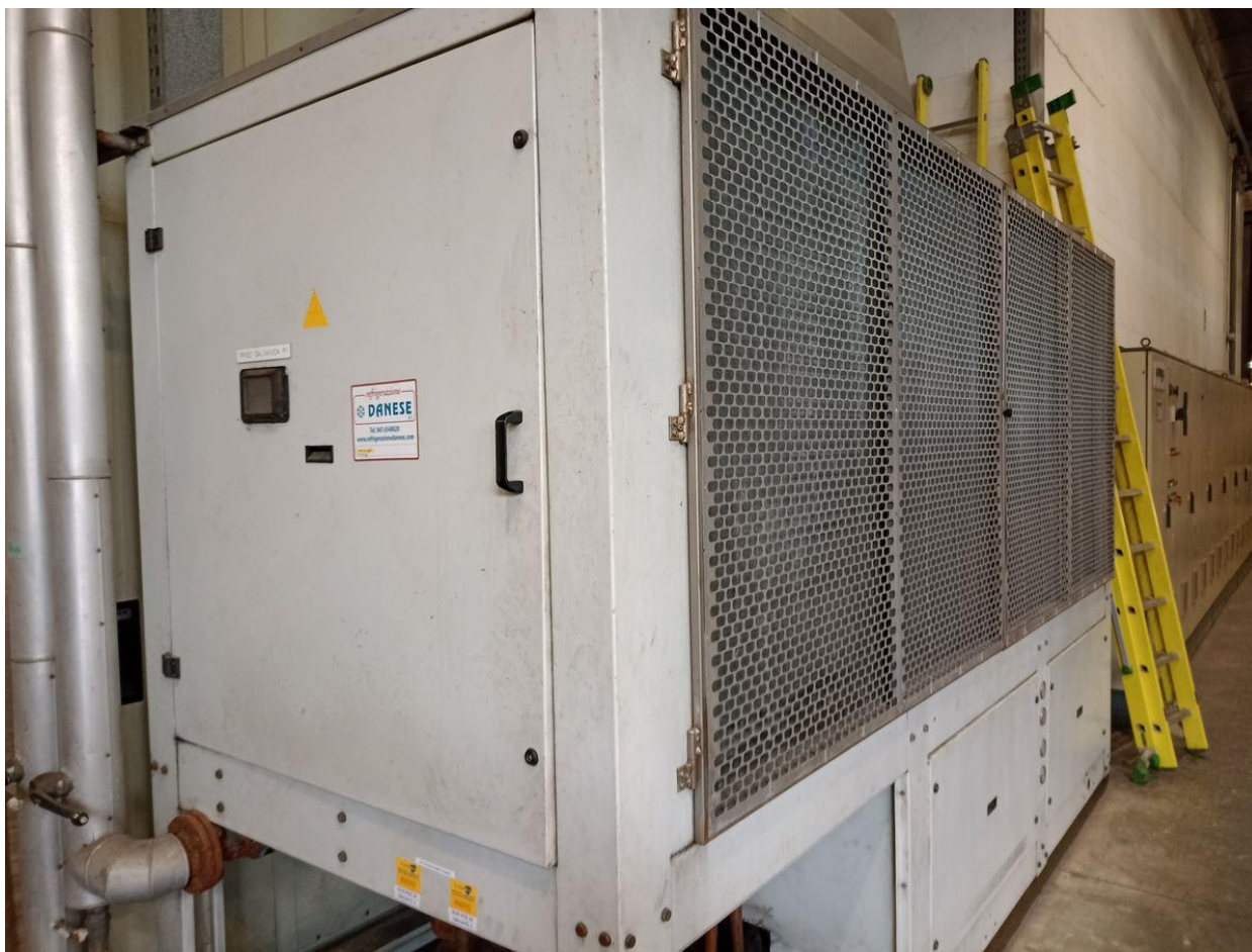
Foto chiller di cui viene valutata la sostituzione
