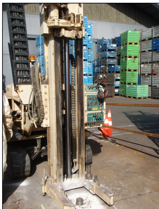
Esecuzione sondaggio con Geoprobe
