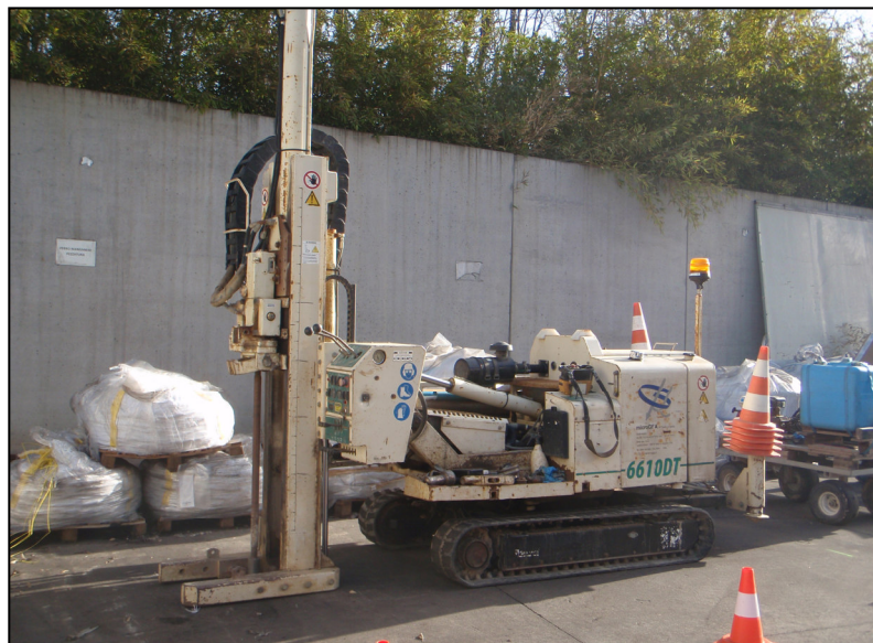
Esecuzione sondaggio con Geoprobe
