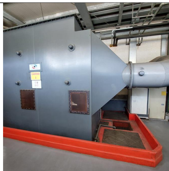
Figura 17 – Torre di abbattimento GALVOSERVICE con bacino di contenimento, camino n. 3
