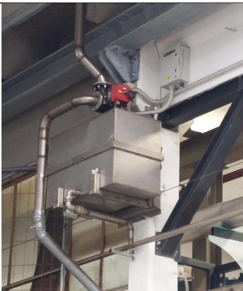
Figura 20: Cisternetta di raccolta delle meteoriche per l'invio all'anello delle acque di recupero
