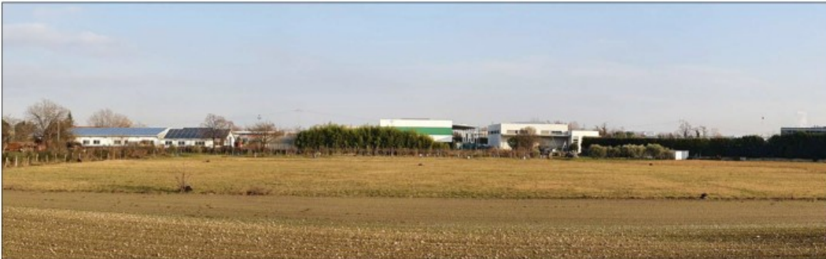
VISTA DA OVEST - STATO DI FATTO
