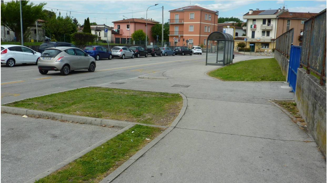
Foto 10: aiuola verde posta a fine intervento
